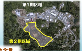
工業団地全景
