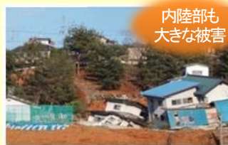
家屋被害の状況（福島市伏拝地内）
