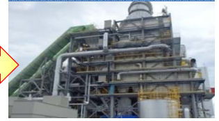
浪江町仮設焼却炉
