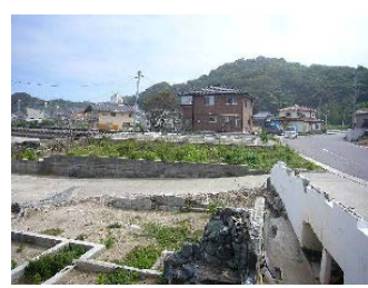
豊間地区着手前状況
