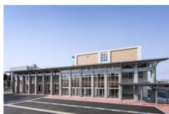
復旧した北校舎東面の様子
