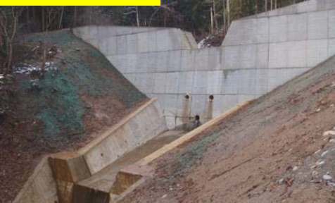
工事実施状況(只見町大字二軒在家地内)
