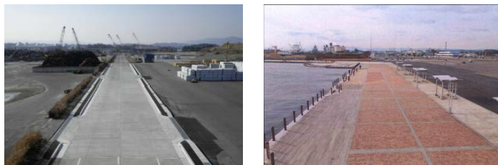
港湾施設の復旧状況
