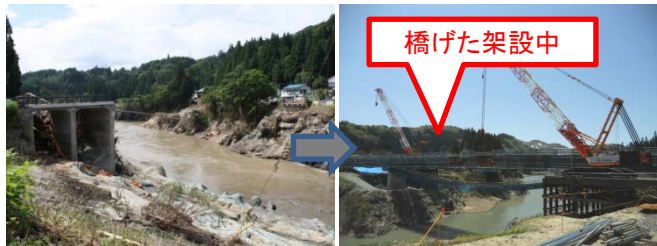
国道252号 二本木橋施工状況
