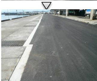
漁港区復旧状況
