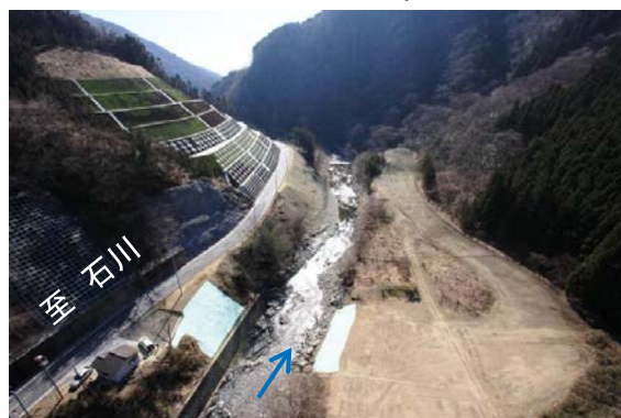
終点側の状況
