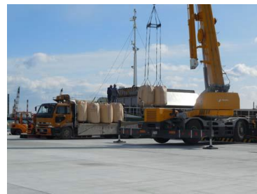
復旧したバース内でトラックへの荷積みを行う様子。
