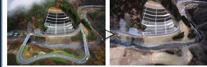
河川の対岸に設置されていた仮道(写真左)が、現在は使用を終え全て撤去されました(写真右)
