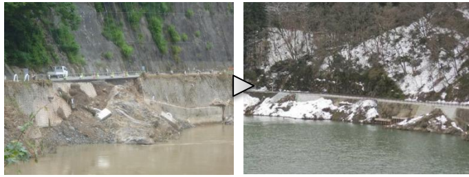
国道459号では崩落した道路路肩部分を復旧させました。
