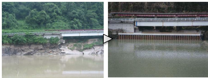
喜多方西会津線では崩落した橋の基礎部分を復旧させました。
