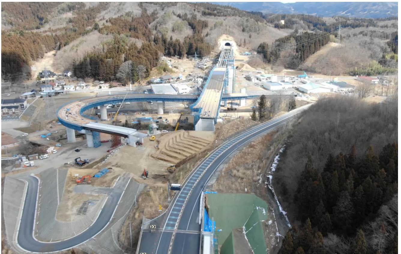
【土木】県道吉間田滝根線広瀬工区（小野町）～中通りと浜通りを結ぶ東西連携道路工事 （あぶくま高原道路小野IC接続部）
