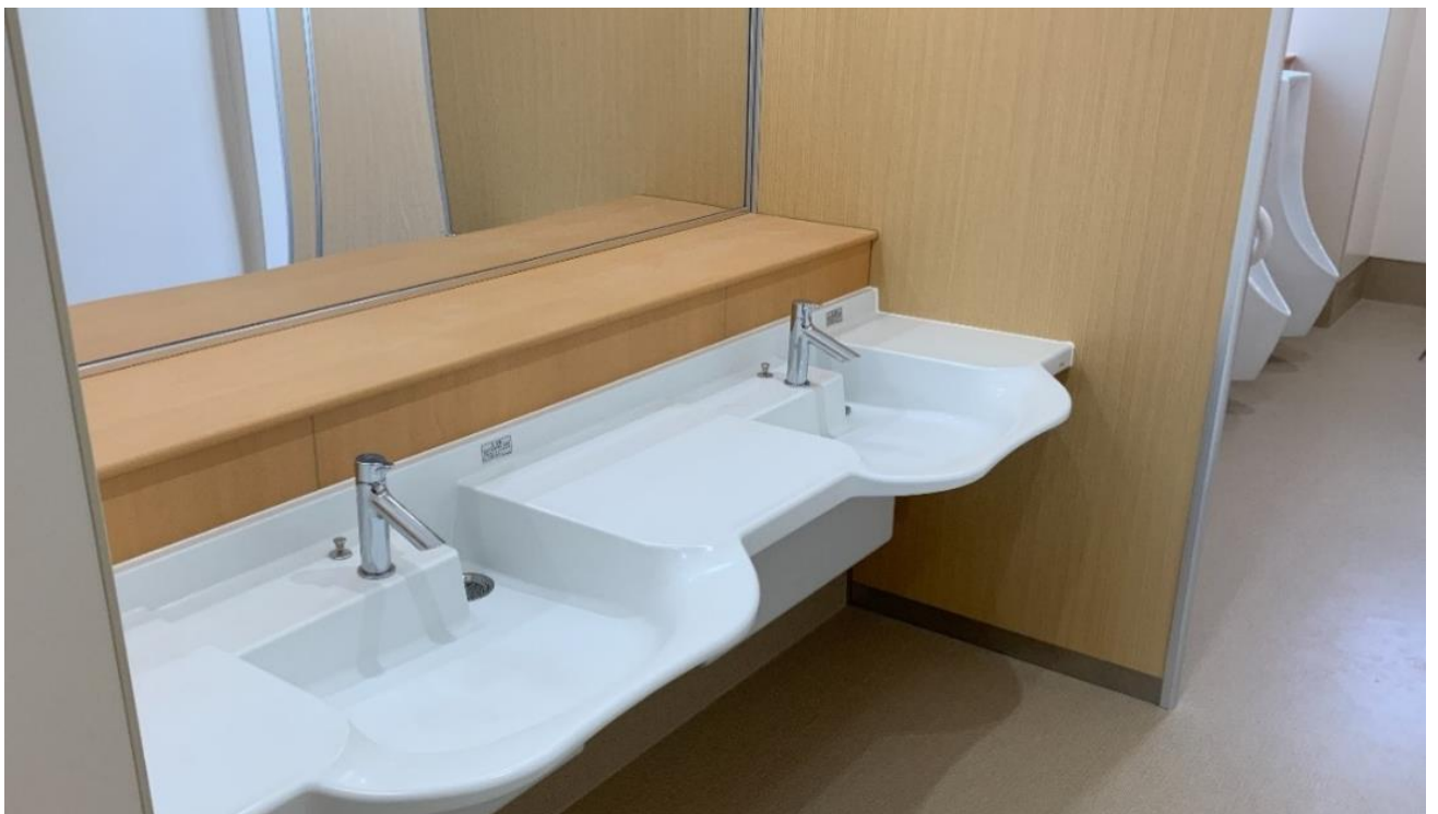
【建築・設備】伊達地区特別支援学校新築（機械）工事（伊達市）
