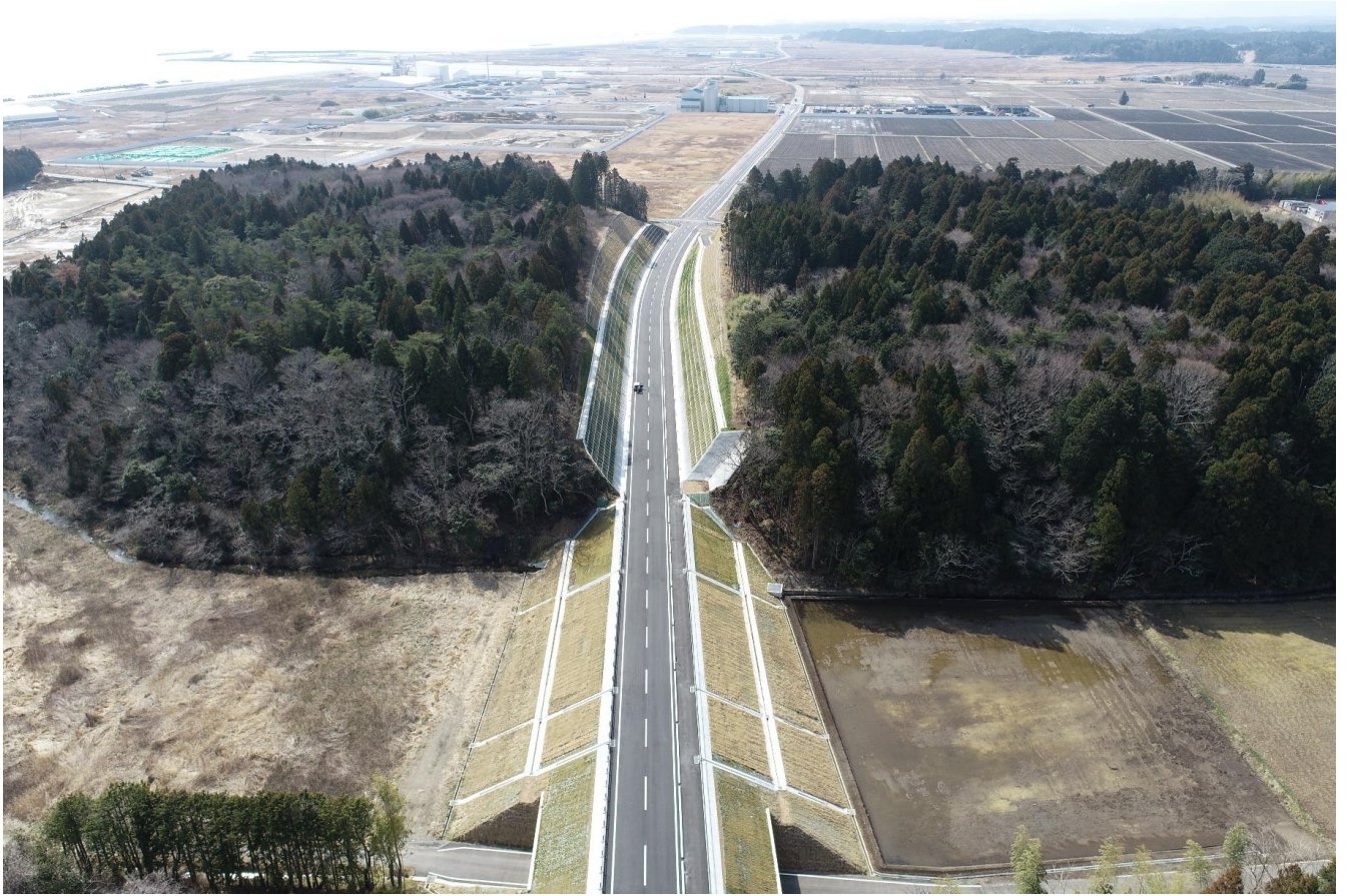
【土木】県道広野小高線棚塩工区（浪江町）～津波被災地域の住民帰還に伴う地域の復興を支援する道路工事 写真-8
