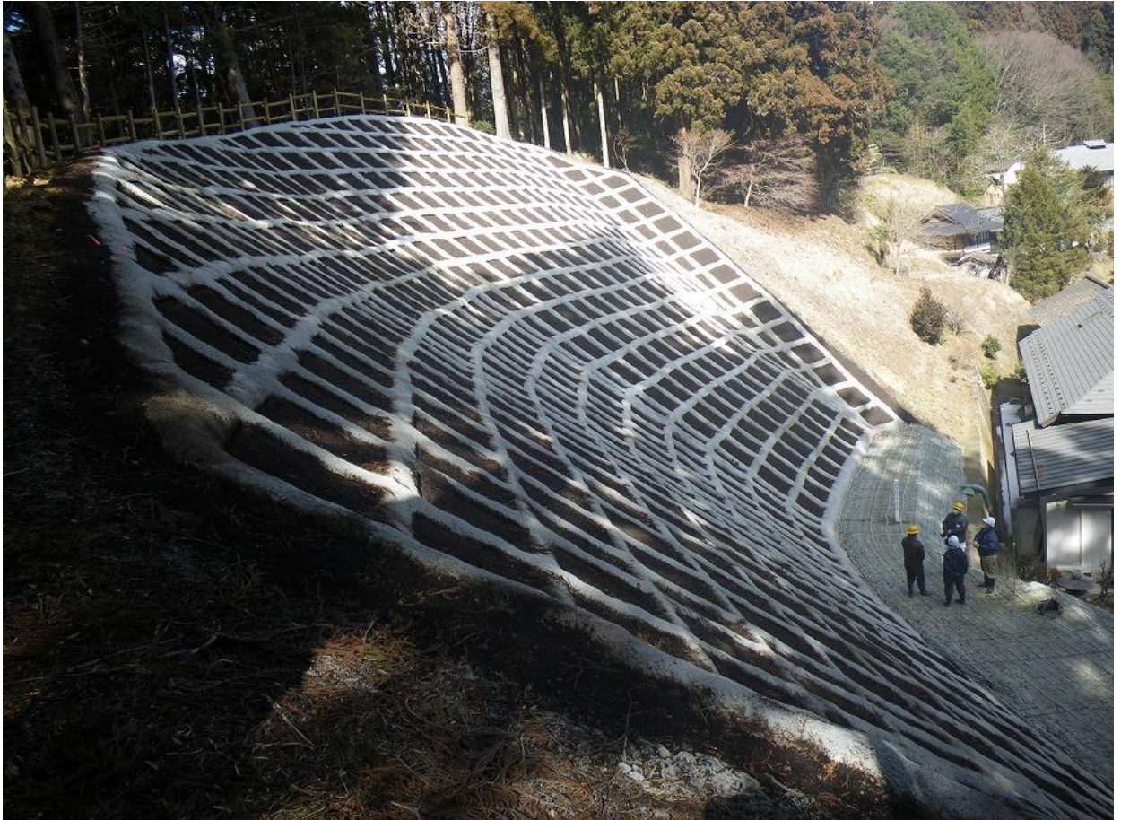
【森林】高野地区山腹工（石川町）～県民の生命・財産を保全する法枠工事
