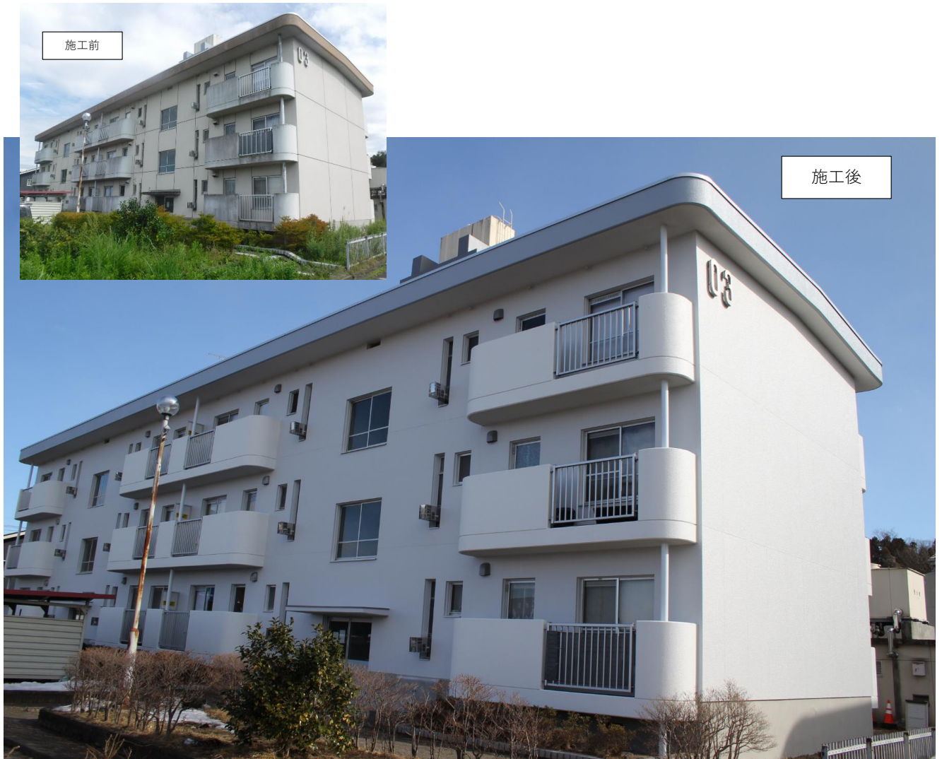
【建築・設備】県営住宅高倉団地外壁改修工事（郡山市）
