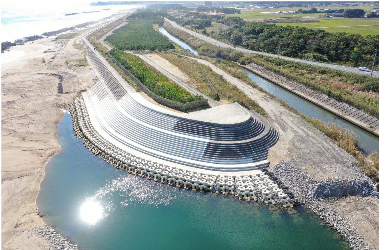
【土木】夏井地区海岸災害復旧工事（いわき市）～津波被害を軽減する海岸堤防の復旧工事
