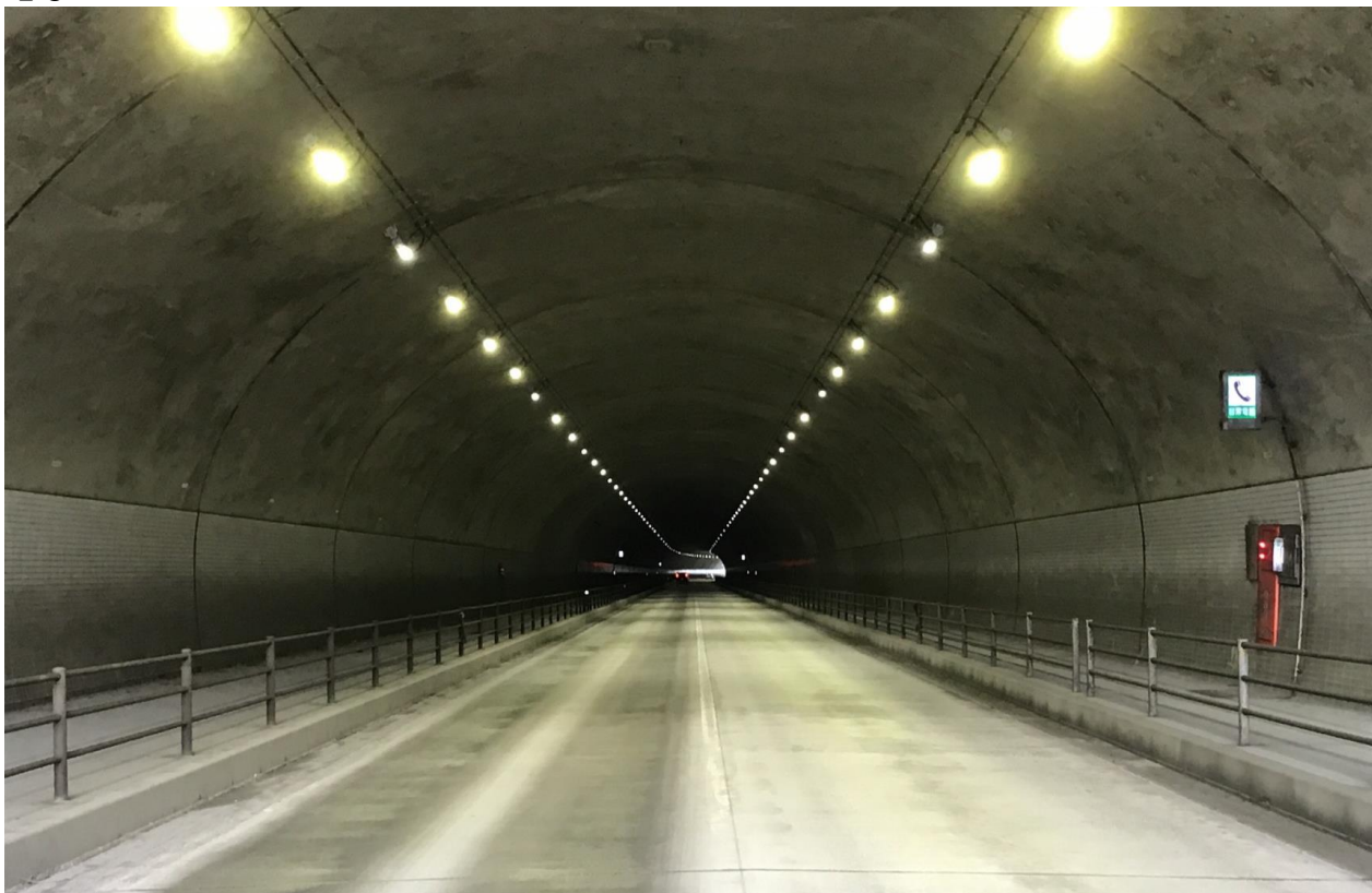
【建築・設備】国道114号絵馬平トンネル道路照明改修工事（福島市）
