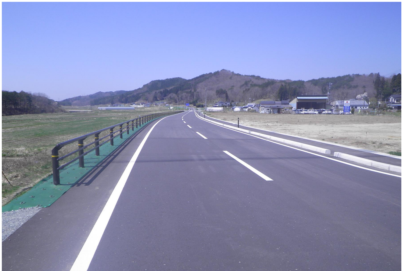
【土木】県道原町川俣線二枚橋工区（飯館村）～避難解除区域の復興を周辺地域から支援するための道路工事
