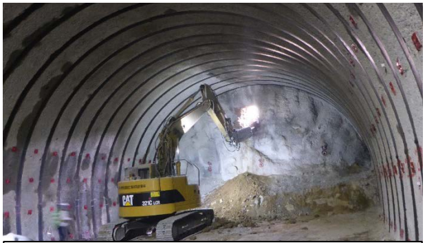
国道114号 川俣町工区関場トンネル 令和4年3月2日 貫通
