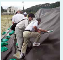
仮置場現地視察会の様子
