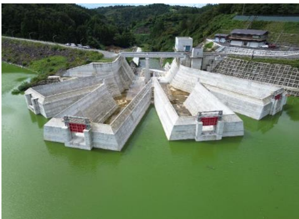
【平常時最高水位付近】
