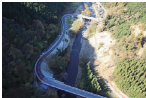
応急復旧（仮道）により交通を確保
