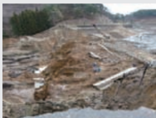
本震により崩壊した灌がい用アースダム 【死者7人、行方不明者1人】（須賀川市長沼）
