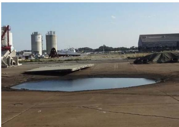
コンクリート舗装の沈下による水たまり
