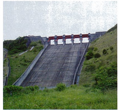
洪水吐ゲート全開操作風景
