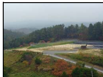
夏井地区仮置場(全景)
