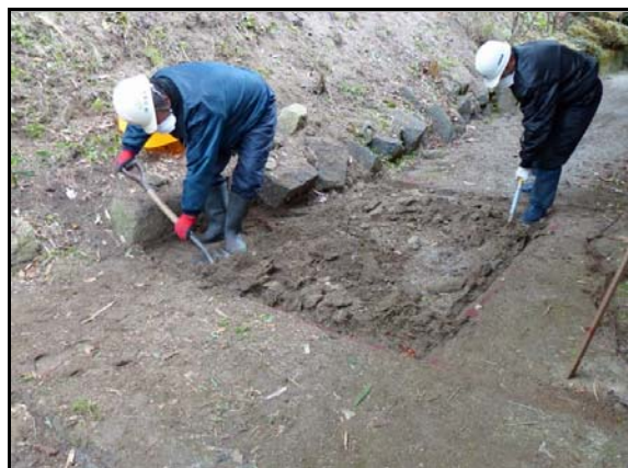
夏井地区除染作業
