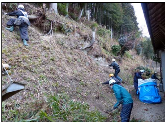
夏井地区除染作業
