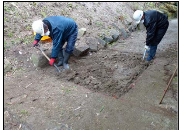
夏井地区除染作業
