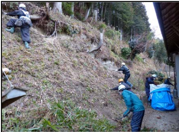
夏井地区除染作業
