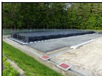
夏井地区仮置場(可燃物)
