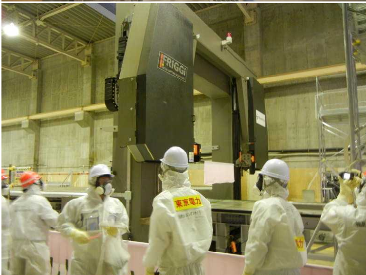
○フランジ型タンクの解体作業について (切断用大型バンドソー)
