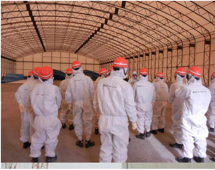
○フランジ型タンクの解体作業について（一時仮置きテント）
