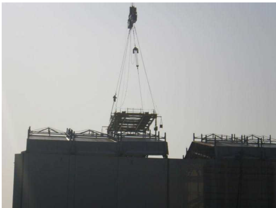
① クレーンで屋根パネル2枚目を吊り上げた瞬間。（午前6時45分）
