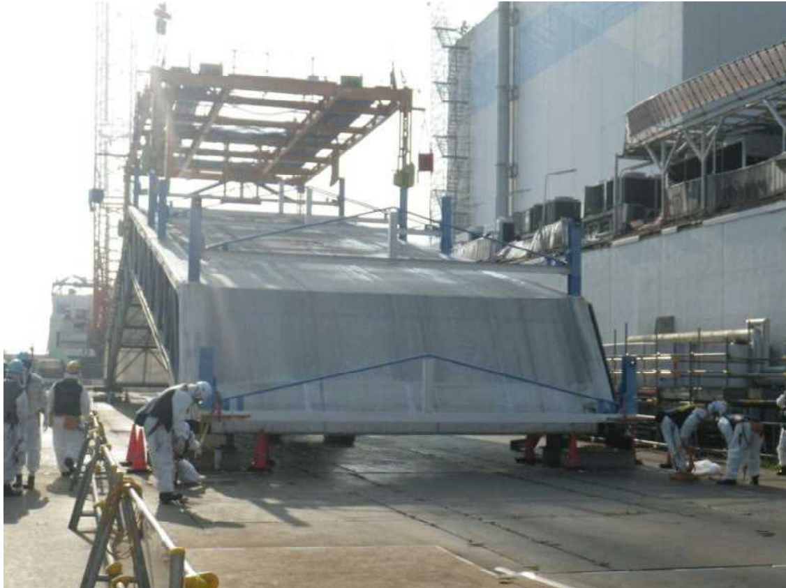
④ 屋根パネルを地面に着座させた状況。(午前7時12分)
