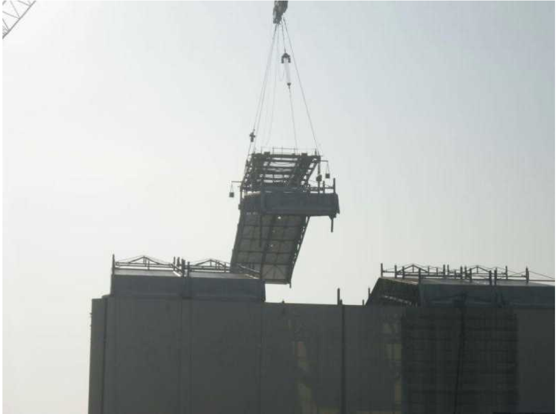
② クレーンで屋根パネルを吊り上げた状況。(午前6時45分)
