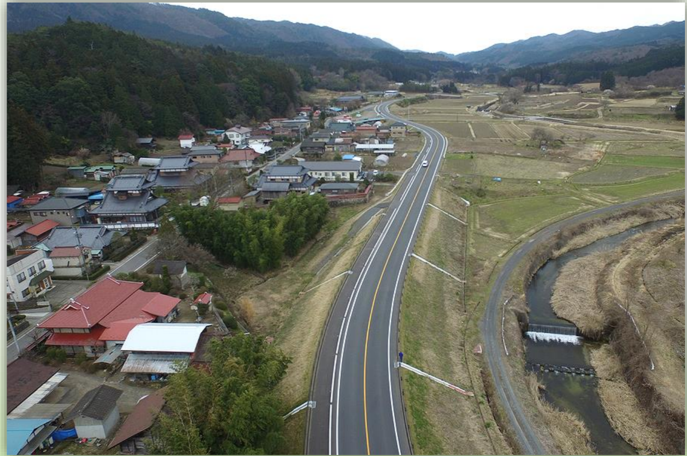
下関1工区を望む(平成28年3月供用開始)
