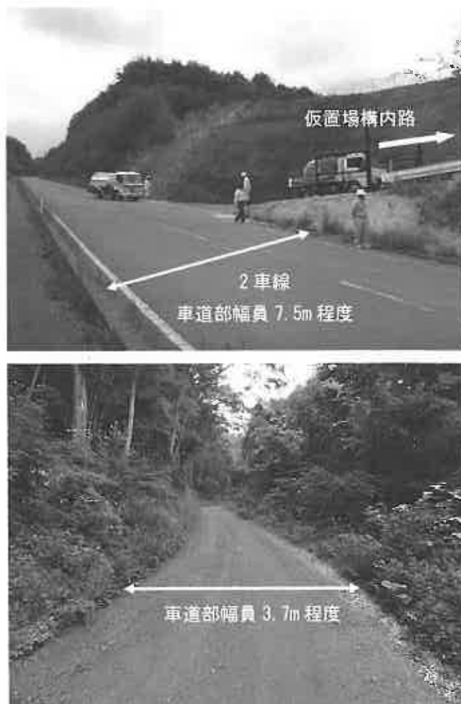
図12 仮置場へのアクセス道路の状況（例）
