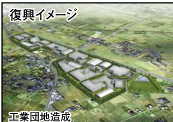
工業団地造成
