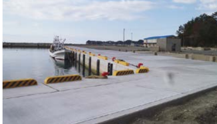
復旧状況(豊間漁港)
