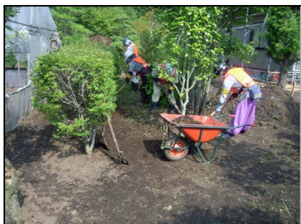
汚染土壌剥ぎ取り作業
