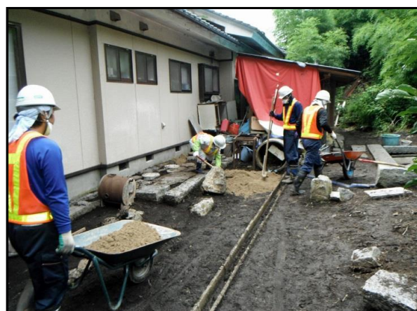
住宅除染実施状況
