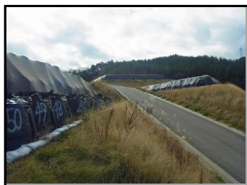
和田地区仮置場
