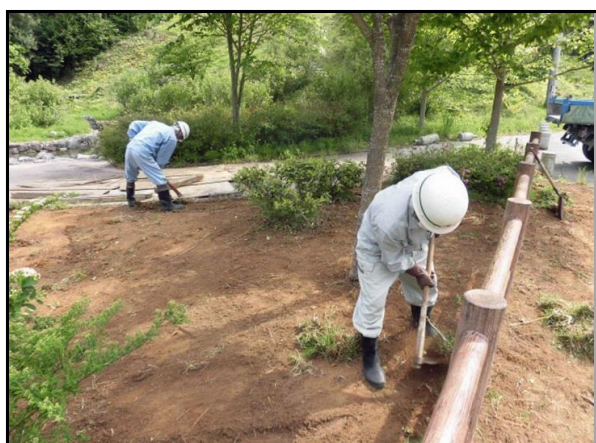
除染作業状況(公園施設)
