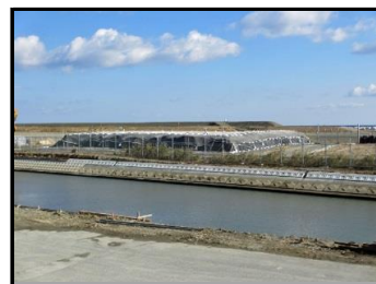
土のう設置状況
