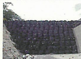
築堤(発電所南側アクセス道路)
