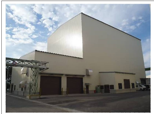
写真-2 仮設焼却施設外観
