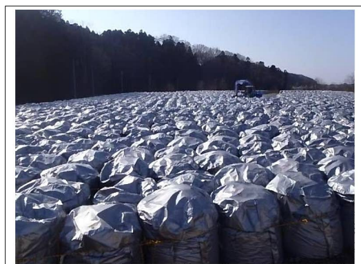
写真-1 フレキシブルコンテナによる保管状況
