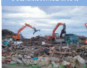
災害廢棄物的處理現場
