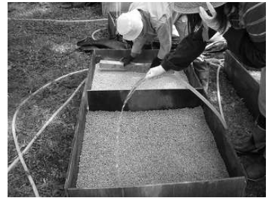
写真 II 5(1)-3 上部を覆土した後、角材で 均し、散水を行う
