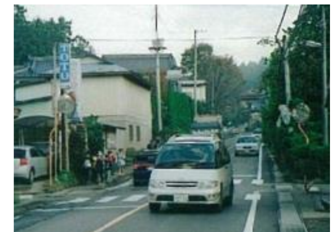
写真3. 棚倉矢吹線現道状況(中島村川原田付近)
