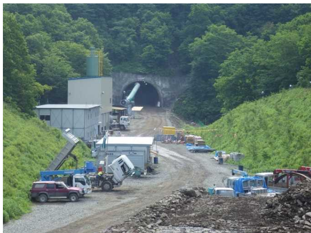
〈国道289号南倉沢トンネル坑口〉
