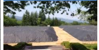
仮置場の状況
