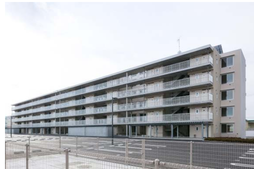
建物全景（北側）
