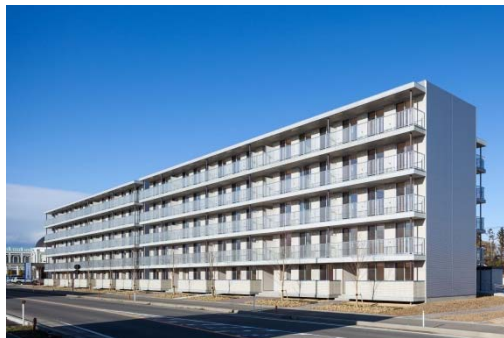
建物全景（南側）
