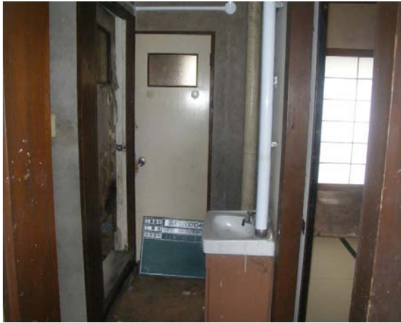
着工前 ホール
