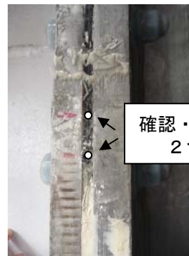
1号機主排気ダクトにおける空気漏えい箇所概略図
