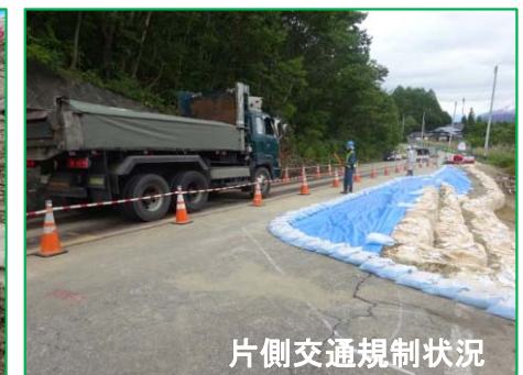
大型土のう積完了
