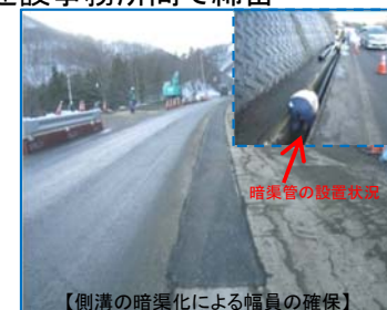
【側溝の暗渠化による幅員の確保】
