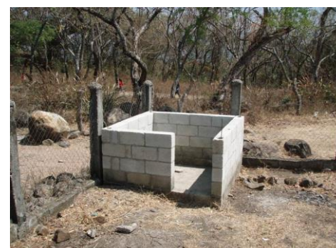
設置工事途中のトイレ
