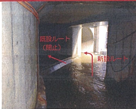
K排水路付替部
