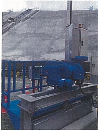
付替排水路ゲート設置状況
