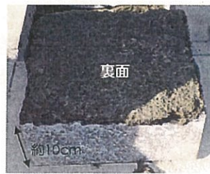
切り出したアスファルト
