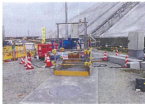
K排水路付替部 (埋戻し済み)
