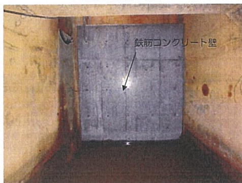
既設ルートの閉止状況
