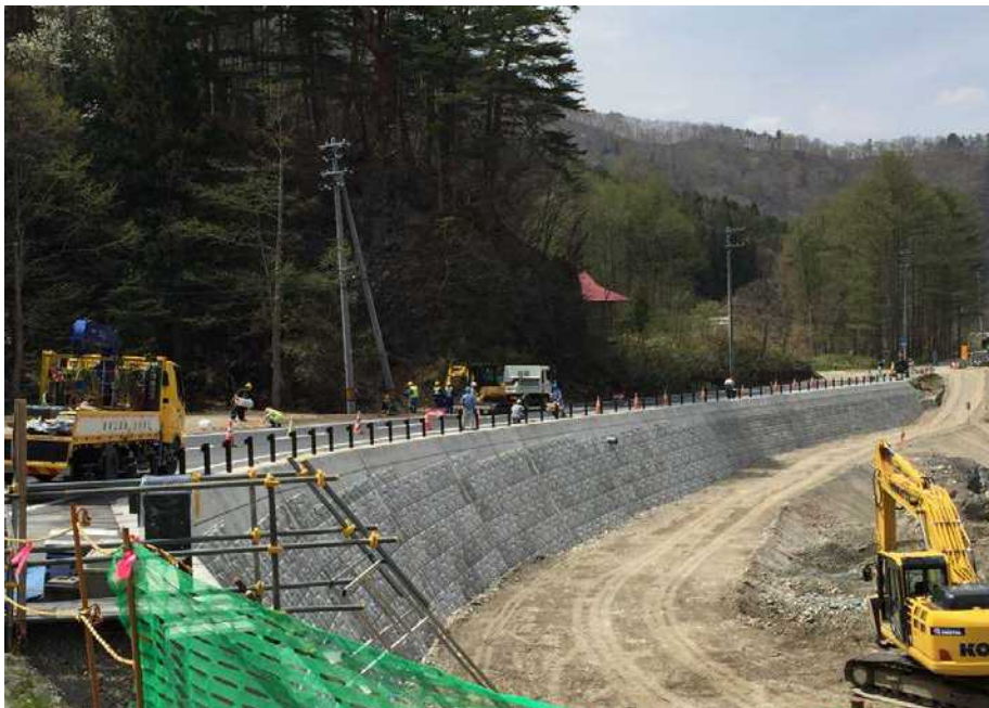
川側擁壁工(平成28年4月25日撮影)
