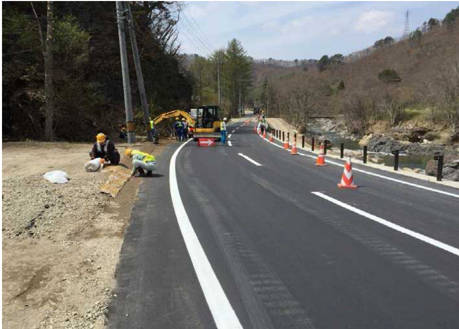
舗装工完了(平成28年4月25日撮影)
