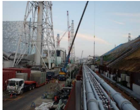
陸側遮水壁の工事完了状況
