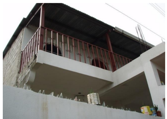
ガラスの埋め込まれたブロック塀
