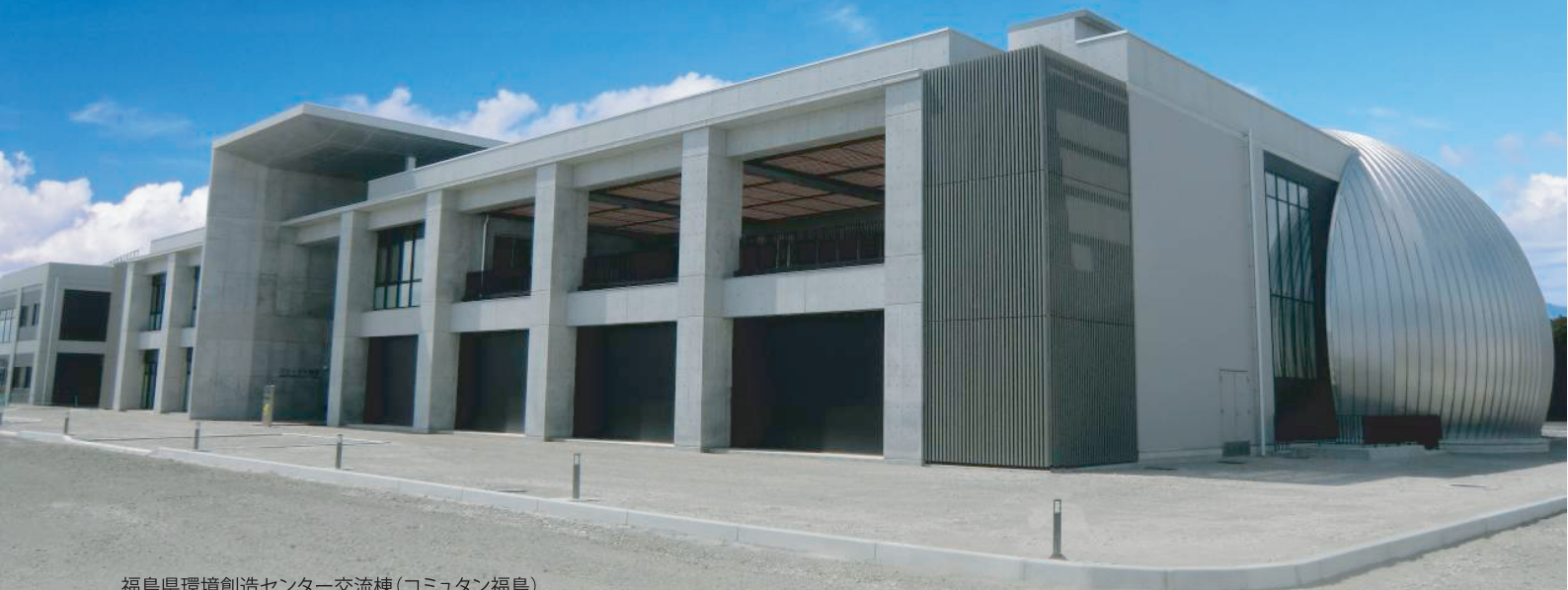
福島県環境創造センター交流棟(コミュタン福島)
