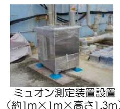
ミュオン測定装置設置 (約1m×1m×高さ1.3m)
