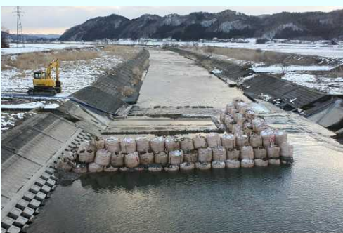
災害復旧事業実施状況
