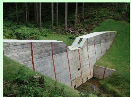
復旧治山事業 豊山地区(棚倉町)の谷止工
