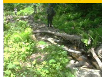
道が流出した箇所
