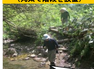
H26 年度施工 吉尾峠 (丸太で階段を設置)
