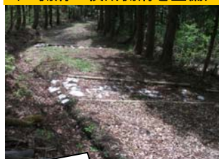
H26 年度施工 美女峠 (土側溝・横断側溝を整備)
