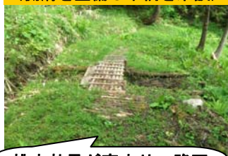
H24・25 年度施工 銀山峠 (側溝を整備し木橋を架設)
