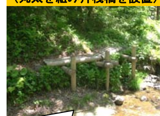
H27 年度施工 吉尾峠 (丸太を組み片棧橋を設置)
