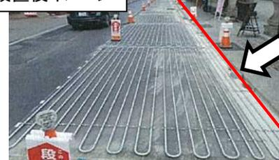
現在施工しているのは、汲み上げた地下水を路面の管へ流したり、冷えた水を地下へ還したりする、大動脈や大静脈のような役割をする管を設置しています。
