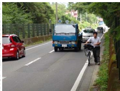
改良工事前の状況
