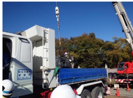
除去土壌等の車両積込状況確認
