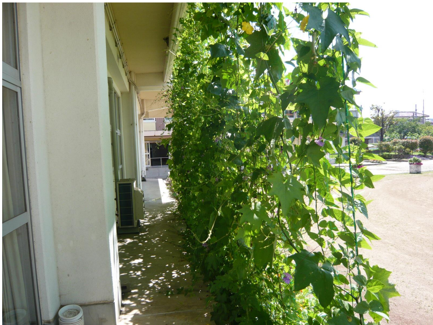
郡山市立小泉小学校 平成28年 8月撮影
