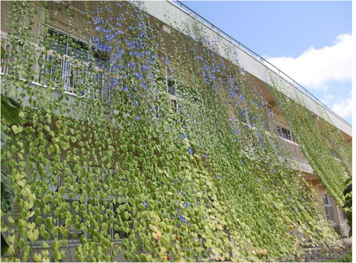
郡山市立桜小学校 平成28年8月撮影
