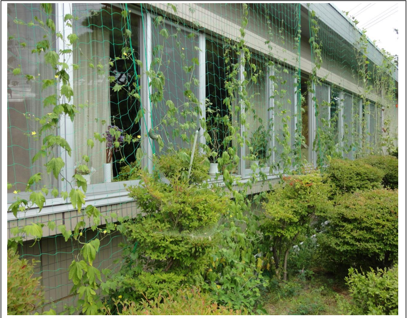
泉崎村立泉崎第一小学校 平成28年8月撮影
