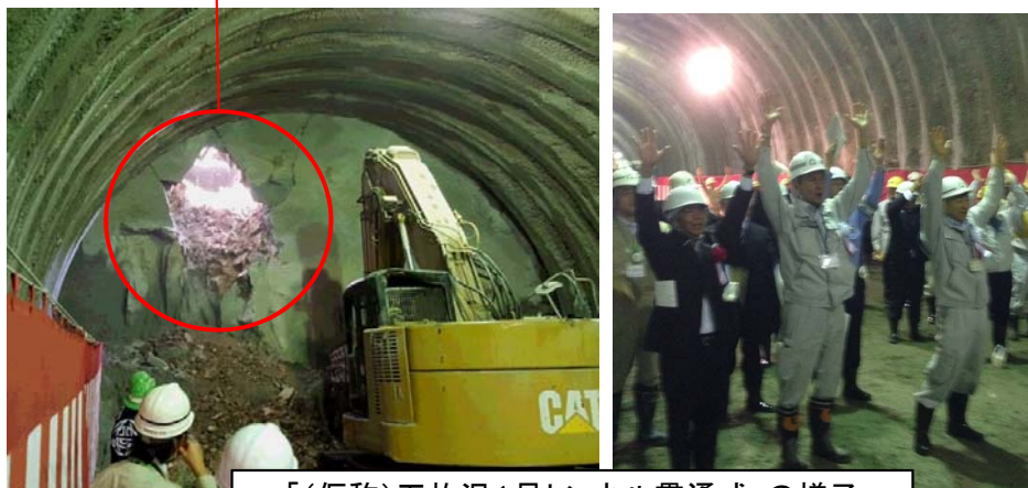
「(仮称)五枚沢1号トンネル貫通式」の様子
